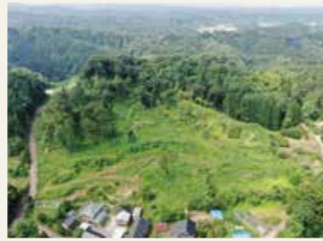
森本地区皆伐再造林(ドローン撮影)
